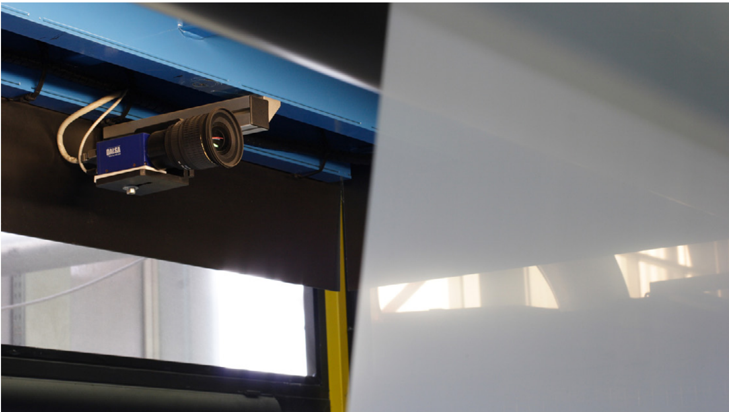
Controllo qualità in linea tramite telecamera
